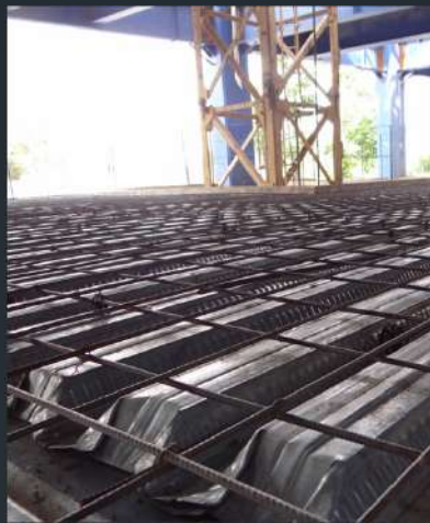
برش و فرم دستی در محل اجرا
